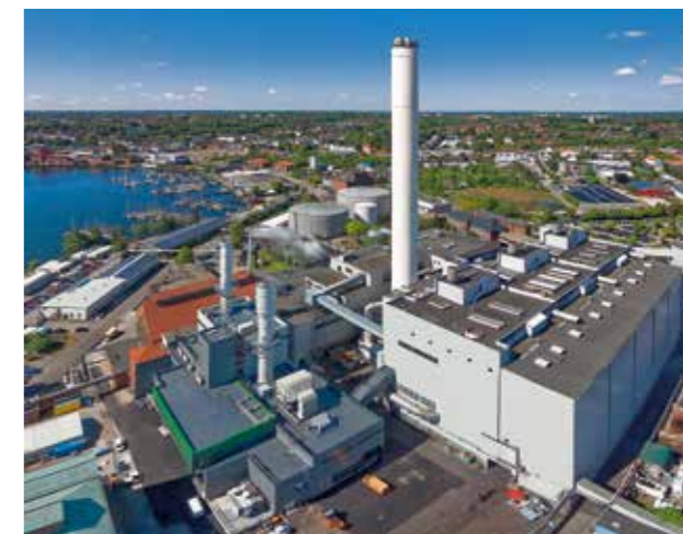
Abbildung 7: Kessel 12-Projekt – Die neue GuD-Anlage beim Flensburger Heizkraftwerk (Quelle: Unternehmensdarstellung)
